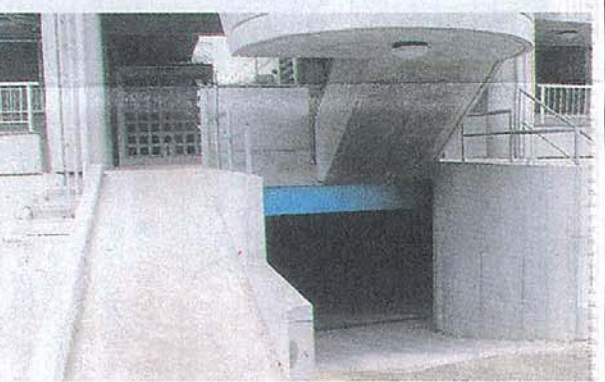
2階へは階段とともにスロープも取り付けられた
