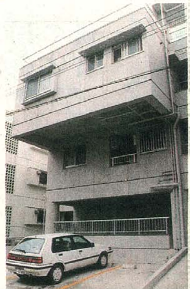
建物の北側部分。各戸をスライドさせた工夫がうかがえる
